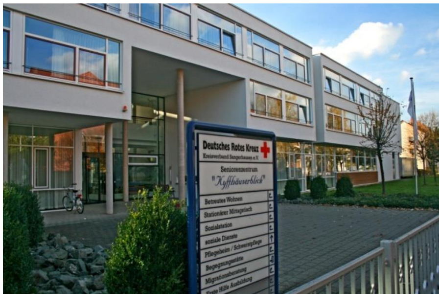
Rys. 6 Dom opieki dla osób starszych ( Seniorzentrum Kyffhäuserblick ) od strony elewacji frontowej
