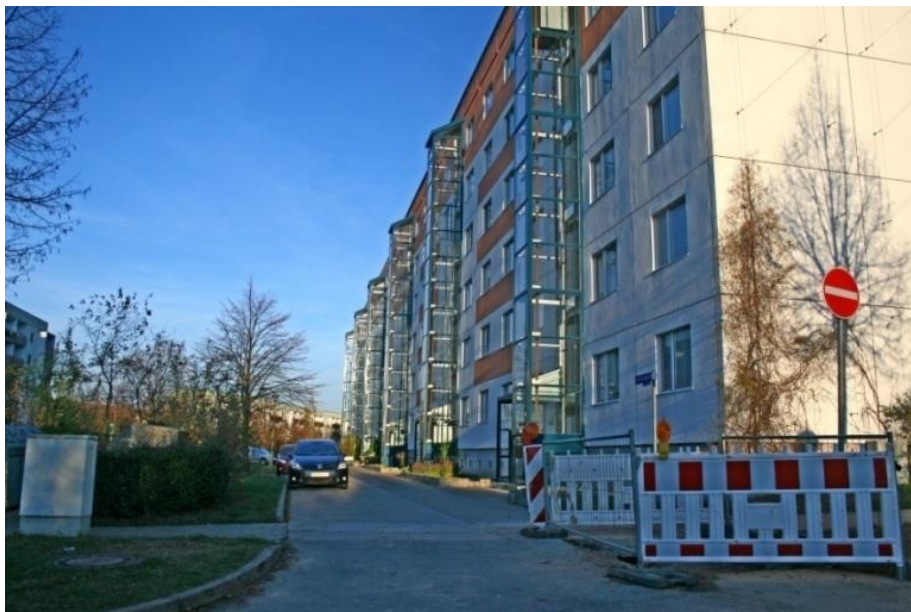
Rys. 12 Dobudowane windy do budynków mieszkalnych w Sangerhausen
