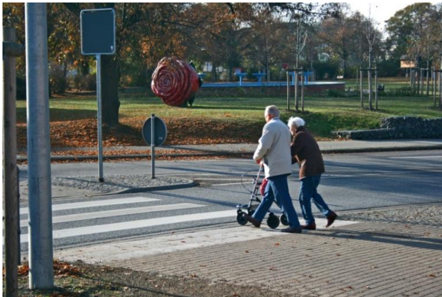
Rys. 15 Obniżone krawężniki w celu łatwego pokonania przeszkody przez wózki osób starszych w Sangerhausen
